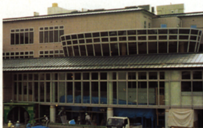
シートが取り外されたこどもみらい館の外観
